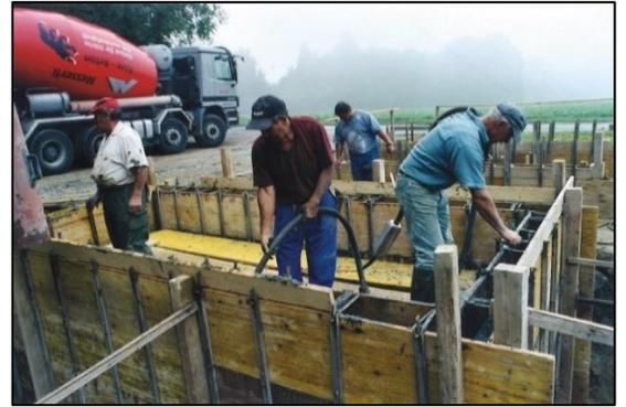
**Einfüllung Fertigbeton Verschalung**
