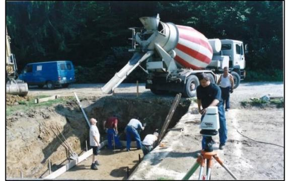
**Anlieferung Fertigbeton Kellerboden**
